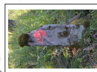
Schwer beschädigt: Stein 71
