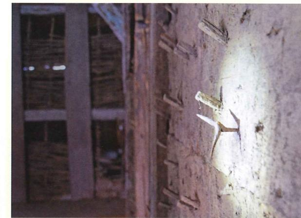
**Foto oben: Die Handwerker wussten sich dereinst zu helfen. Sie nutzten spanische Reiter, eigentlich eine Waffe um Kavallerien aufzuhalten, um den Putz zu befestigen.**
