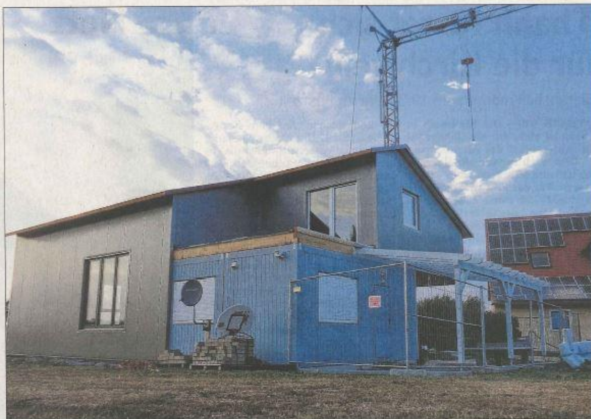
Ein bedeutendes Bauprojekt stellt die Gailrother Dorfscheune dar. Von den Gesamtkosten von rund 135.000 Euro übernimmt die Kommune - nach Abzug der 60-prozentigen Förderung - noch etwa 54.000 Euro. Foto: Peter Sennfelder
