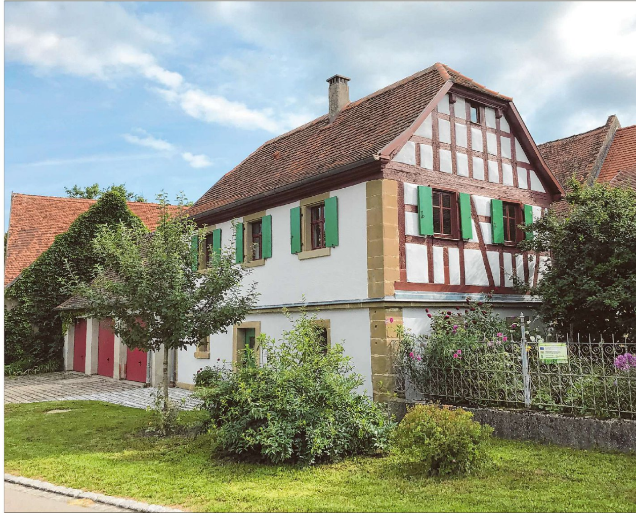
In Binzwangen bei Colmberg wurde aus diesem ehemaligen Austragungshaus eine Pilger- und Radlerherberge. Die LAG konnte für dieses Projekt umfangreiche Fördermittel mobilisieren. Foto: Pia Grimmeiß-Haider
