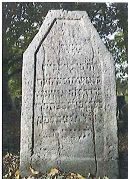
**Abb. 4: Grabmal aus Blasensandstein für den 1832 gestorbenen Vels ben Mosche. Der stark gefährdete Stein (drei parallele Vertikallrisse) wurde 2019 durch Fa. Bauer-Bornemann Steinkonservierung gesichert und konserviert (Rissverschluss, Vernadelung).** Foto: Felix Groß
