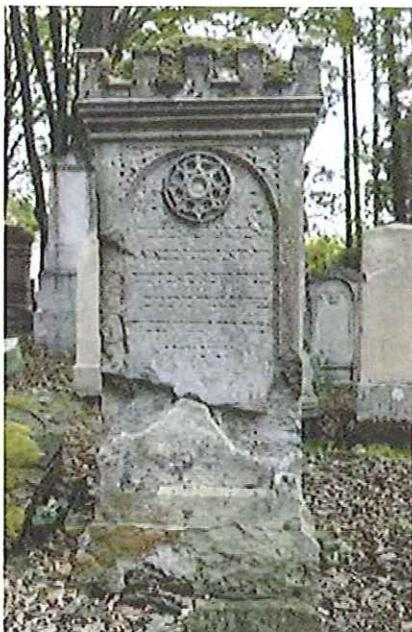
**Abb. 11: Dieses Grabzelenchen aus feinkörnigem Sandstein weist Sockelschäden durch aufsteigende Feuchte im Quellbereich sowie Vandalismusschaden (Abschlagen) auf.** Foto: Günter Schmidt
