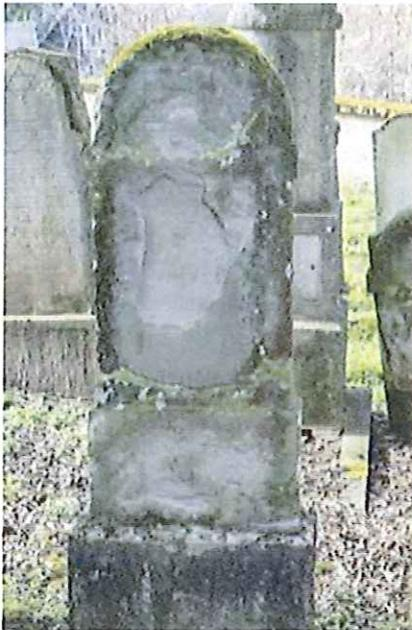
**Abb. 13: Grabmale aus feinkörnigen Sandsteinen, wie z.B. der grünliche Schiffsandstein, zeigen häufig intensive Schalenbildung und großflächiges Abplatzen.**
